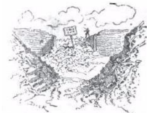
La Porte de Chine après sa destruction.
